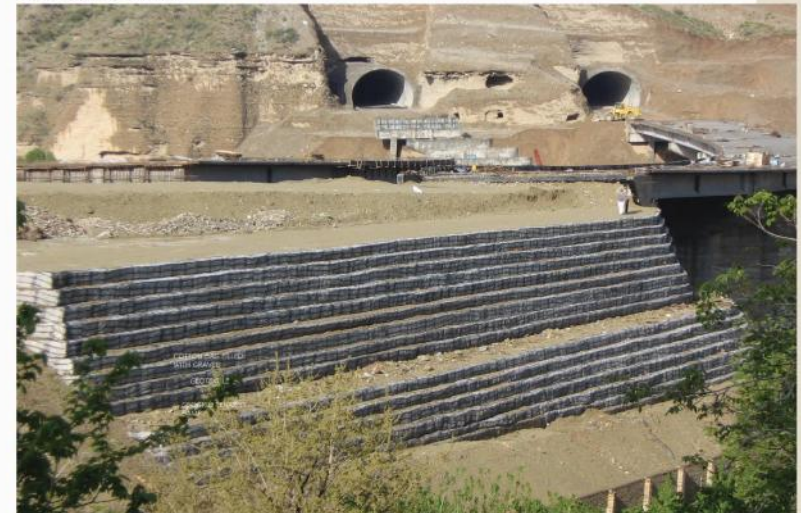
پل جاجرد آزاد راه تهران - پردیس
