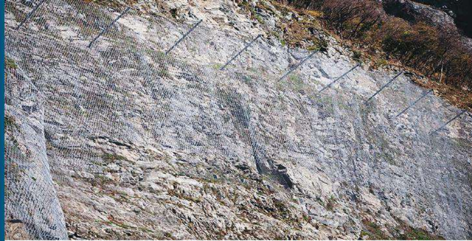
کنترل ریزش سنگ با استفاده از سیستم مرکب ، ▲ که در واقع ترکیبی از هر دو سیستم فعال و غیر فعال می باشد.
